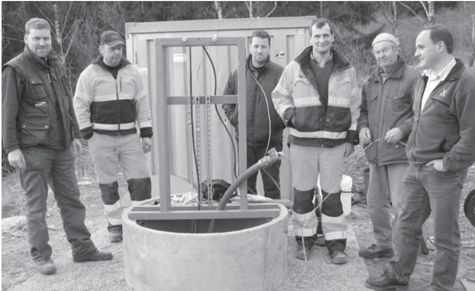
Arbeiten bei der Probebohrung zur eventuellen Errichtung eines Trinkwassertiefbohrbrunnens. Im Bild von links nach rechts: Georg Schweitzer, Herbert Innerhofer, Florian Gamper, Adolf Tappeiner, Adolf Forcher und Pius Abler. Foto von Albert Bernhart)
