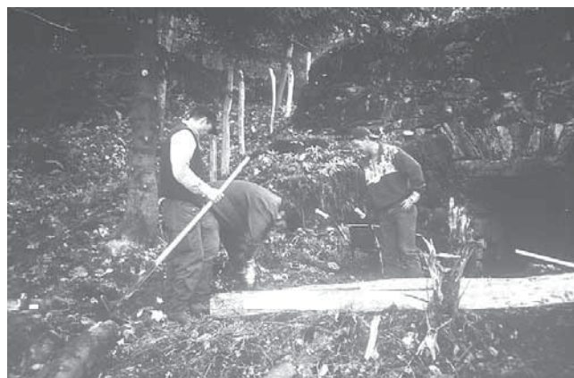
Hias Pircher, Ernst Alber und Sighart Ritsch bei der Renovierung des wertvollen Bauwerkes.
